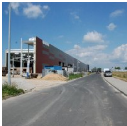
Zatorska Strefa Aktywności Gospodarczej FOTOGALERIA - czerwiec 2017
