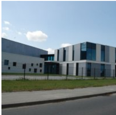
Zatorska Strefa Aktywności Gospodarczej FOTOGALERIA - czerwiec 2017
