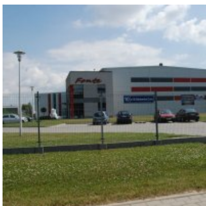
Zatorska Strefa Aktywności Gospodarczej FOTOGALERIA - czerwiec 2017
