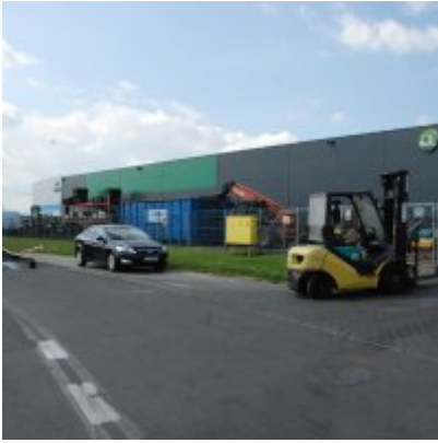
Zatorska Strefa Aktywności Gospodarczej FOTOGALERIA - czerwiec 2017
