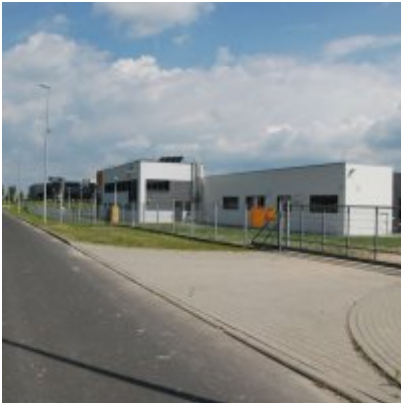
Zatorska Strefa Aktywności Gospodarczej FOTOGALERIA - czerwiec 2017
