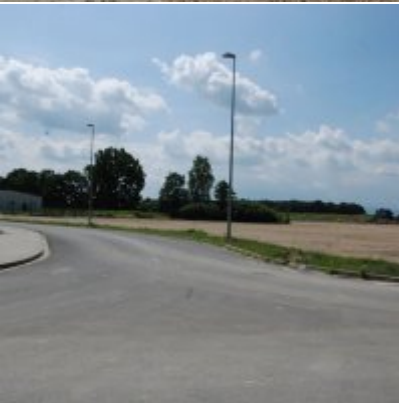
Zatorska Strefa Aktywności Gospodarczej FOTOGALERIA - czerwiec 2017
