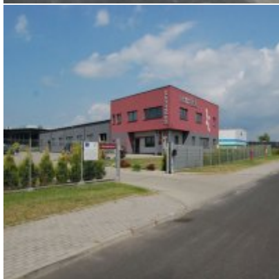
Zatorska Strefa Aktywności Gospodarczej FOTOGALERIA - czerwiec 2017
