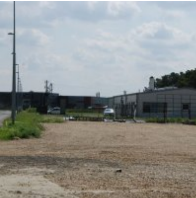
Zatorska Strefa Aktywności Gospodarczej FOTOGALERIA - czerwiec 2017
