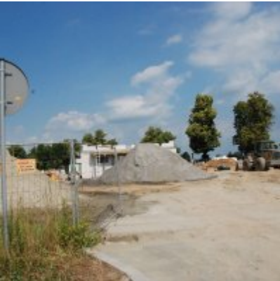
Zatorska Strefa Aktywności Gospodarczej FOTOGALERIA - czerwiec 2017
