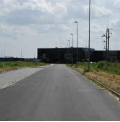
Zatorska Strefa Aktywności Gospodarczej FOTOGALERIA - czerwiec 2017
