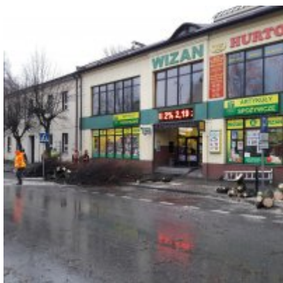
Wycinka drzew w obrębie Zatorskiego rynku
