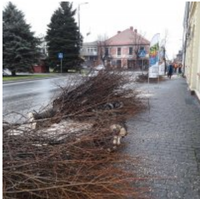
Wycinka drzew w obrębie Zatorskiego rynku
