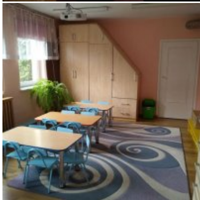
Wakacyjny remont w Samorządowym Przedszkolu "Złota Rybka" w Zatorze
