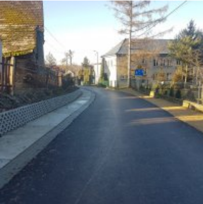
Zakończono przebudowę drogi gminnej - ul. Grabskiego
