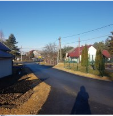
Zakończono przebudowę drogi gminnej - ul. Grabskiego
