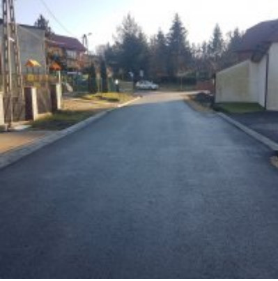
Zakończono przebudowę drogi gminnej - ul. Grabskiego
