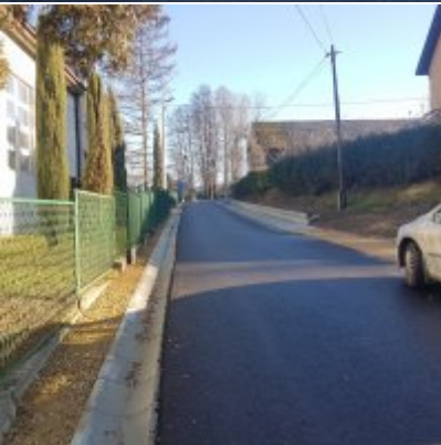
Zakończono przebudowę drogi gminnej - ul. Grabskiego
