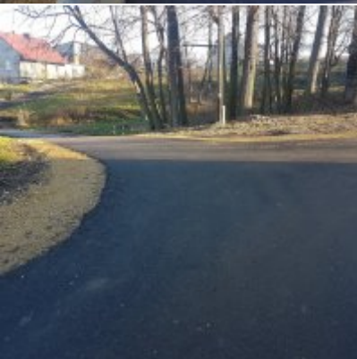
Zakończono przebudowę drogi gminnej - ul. Grabskiego
