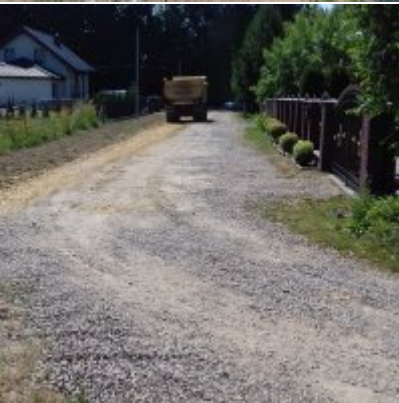
Rozpoczęto prace modernizacyjne na ul. Grunwaldzkiej
