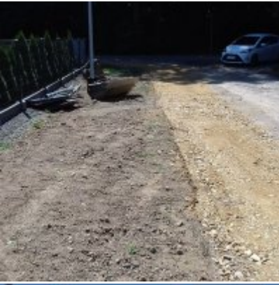
Rozpoczęto prace modernizacyjne na ul. Grunwaldzkiej
