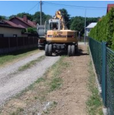
Rozpoczęto prace modernizacyjne na ul. Grunwaldzkiej
