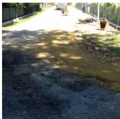
Rozpoczęto prace modernizacyjne na ul. Grunwaldzkiej
