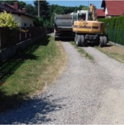
Rozpoczęto prace modernizacyjne na ul. Grunwaldzkiej
