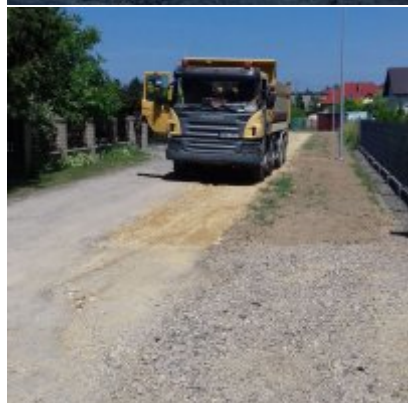
Rozpoczęto prace modernizacyjne na ul. Grunwaldzkiej
