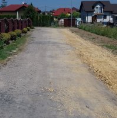
Rozpoczęto prace modernizacyjne na ul. Grunwaldzkiej
