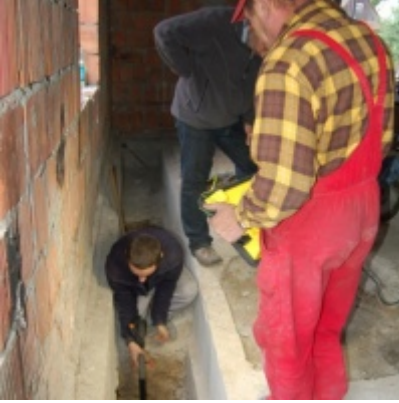
Rozbudowa i remont budynków Urzędu Miejskiego 2008/2010.
