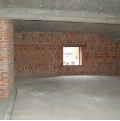
Rozbudowa i remont budynków Urzędu Miejskiego 2008/2010
