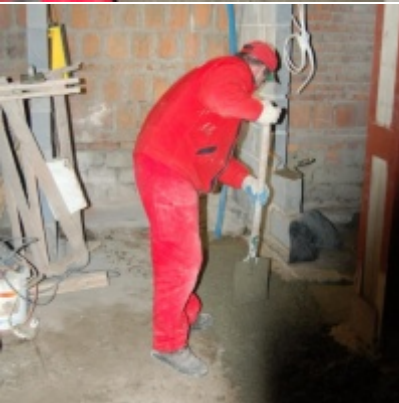
Rozbudowa i remont budynków Urzędu Miejskiego 2008/2010.
