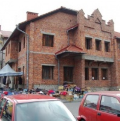
Rozbudowa i remont budynków Urzędu Miejskiego 2008/2010
