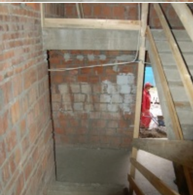
Rozbudowa i remont budynków Urzędu Miejskiego 2008/2010.
