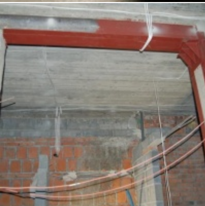
Rozbudowa i remont budynków Urzędu Miejskiego 2008/2010.
