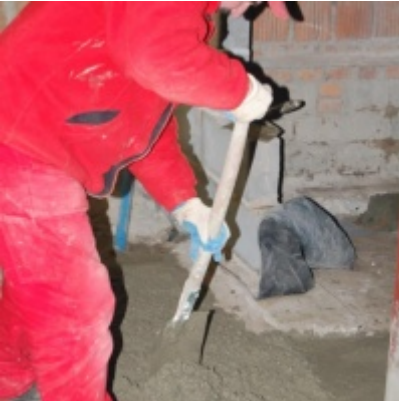
Rozbudowa i remont budynków Urzędu Miejskiego 2008/2010.
