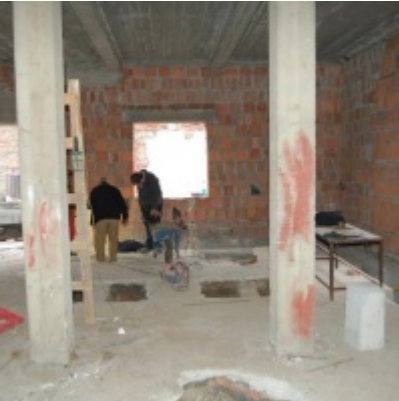
Rozbudowa i remont budynków Urzędu Miejskiego 2008/2010.
