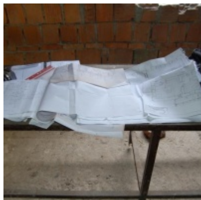
Rozbudowa i remont budynków Urzędu Miejskiego 2008/2010
