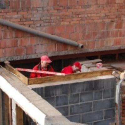
Rozbudowa i remont budynków Urzędu Miejskiego 2008/2010.
