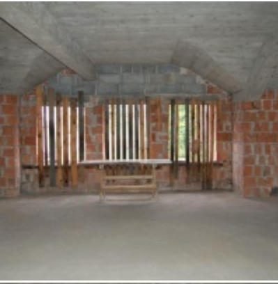
Rozbudowa i remont budynków Urzędu Miejskiego 2008/2010
