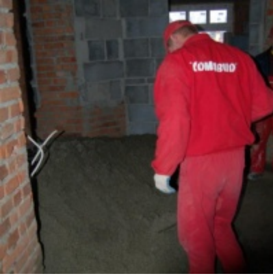
Rozbudowa i remont budynków Urzędu Miejskiego 2008/2010.
