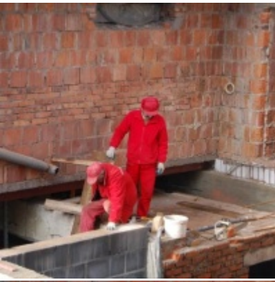
Rozbudowa i remont budynków Urzędu Miejskiego 2008/2010.
