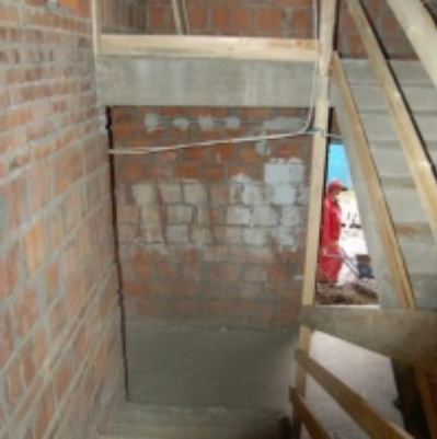
Rozbudowa i remont budynków Urzędu Miejskiego 2008/2010.
