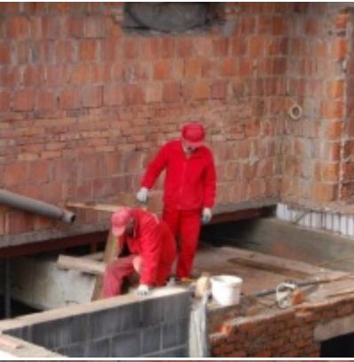
Rozbudowa i remont budynków Urzędu Miejskiego 2008/2010.
