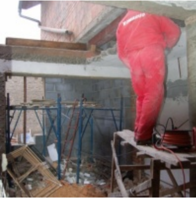
Rozbudowa i remont budynków Urzędu Miejskiego 2008/2010.
