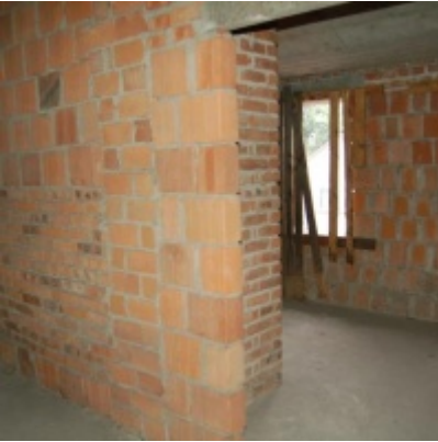
Rozbudowa i remont budynków Urzędu Miejskiego 2008/2010
