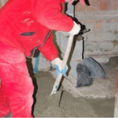
Rozbudowa i remont budynków Urzędu Miejskiego 2008/2010.
