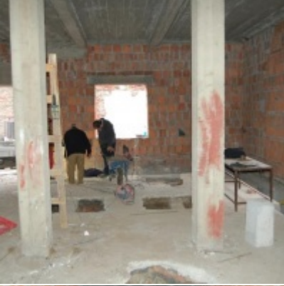
Rozbudowa i remont budynków Urzędu Miejskiego 2008/2010.
