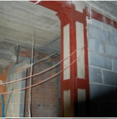
Rozbudowa i remont budynków Urzędu Miejskiego 2008/2010.
