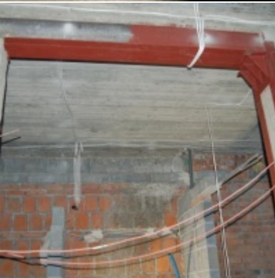
Rozbudowa i remont budynków Urzędu Miejskiego 2008/2010.
