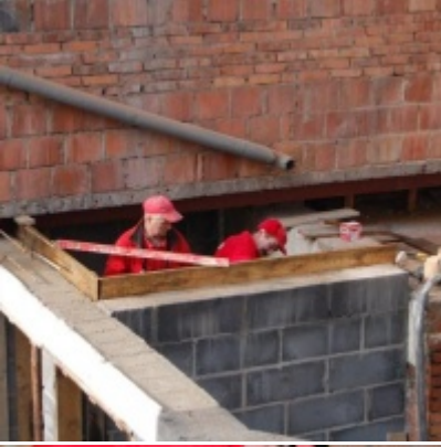
Rozbudowa i remont budynków Urzędu Miejskiego 2008/2010.
