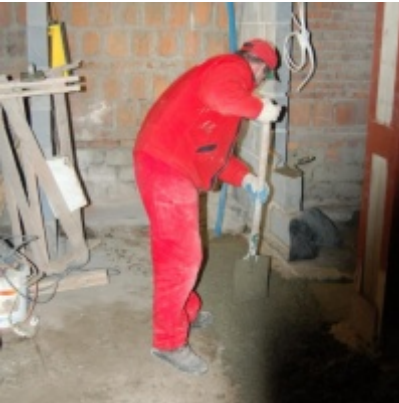
Rozbudowa i remont budynków Urzędu Miejskiego 2008/2010.
