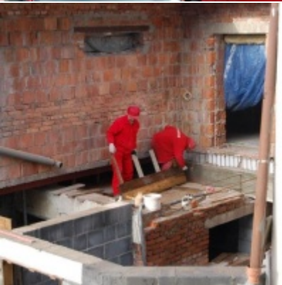
Rozbudowa i remont budynków Urzędu Miejskiego 2008/2010
