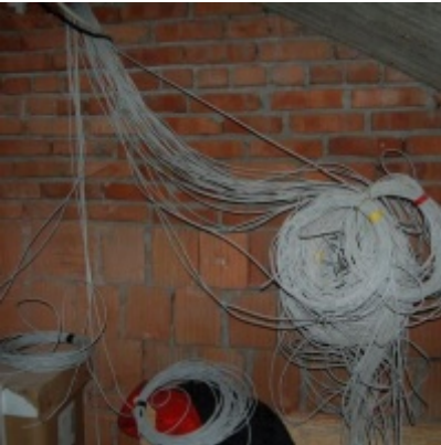
Rozbudowa i remont budynków Urzędu Miejskiego 2008/2010.
