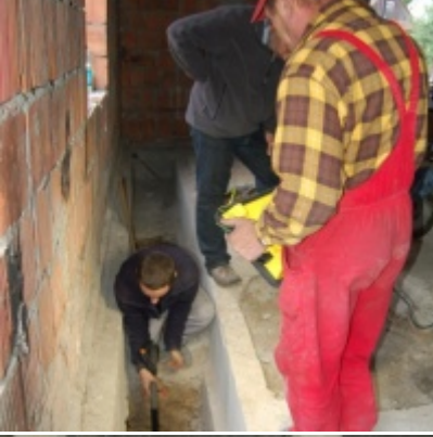
Rozbudowa i remont budynków Urzędu Miejskiego 2008/2010.
