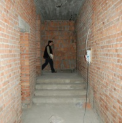
Rozbudowa i remont budynków Urzędu Miejskiego 2008/2010.
