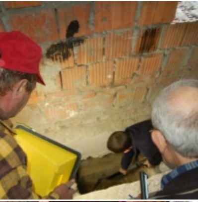
Rozbudowa i remont budynków Urzędu Miejskiego 2008/2010.
