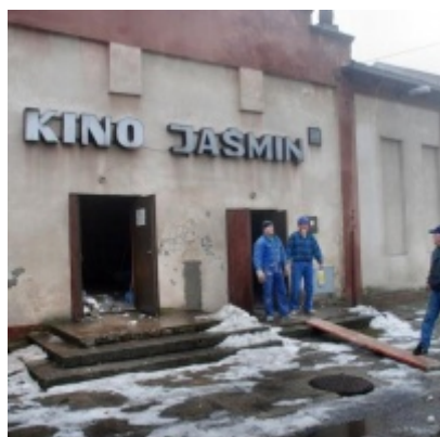
Rozbudowa i remont Regionalnego Ośrodka Kultury
