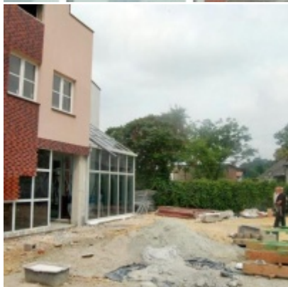
Rozbudowa i remont Regionalnego Ośrodka Kultury
