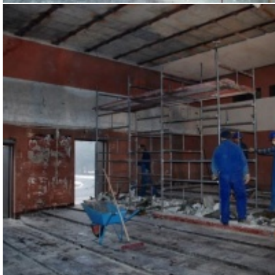
Rozbudowa i remont Regionalnego Ośrodka Kultury
