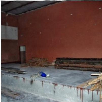
Rozbudowa i remont Regionalnego Ośrodka Kultury
