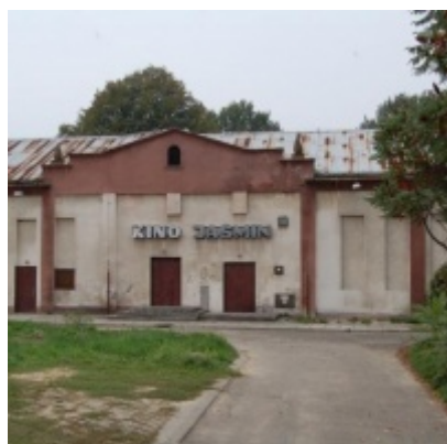
Rozbudowa i remont Regionalnego Ośrodka Kultury
