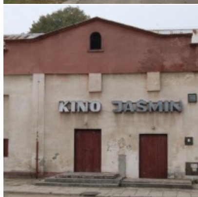
Rozbudowa i remont Regionalnego Ośrodka Kultury
