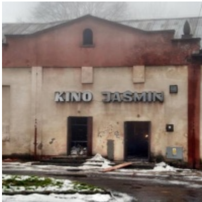
Rozbudowa i remont Regionalnego Ośrodka Kultury
