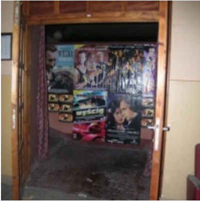
Rozbudowa i remont Regionalnego Ośrodka Kultury
