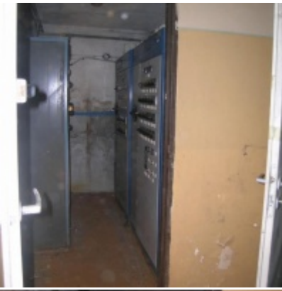
Rozbudowa i remont Regionalnego Ośrodka Kultury
