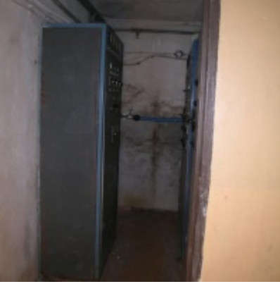
Rozbudowa i remont Regionalnego Ośrodka Kultury
