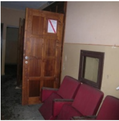
Rozbudowa i remont Regionalnego Ośrodka Kultury
