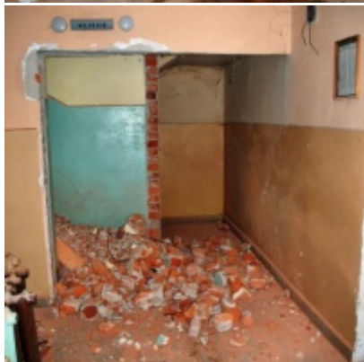
Rozbudowa i remont Regionalnego Ośrodka Kultury
