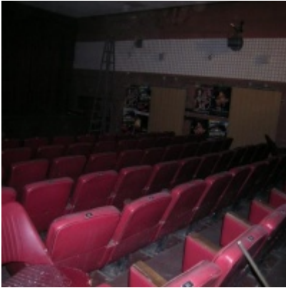
Rozbudowa i remont Regionalnego Ośrodka Kultury
