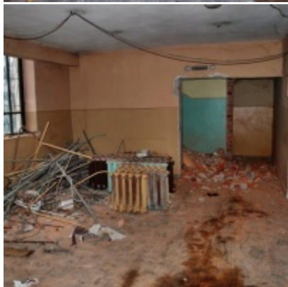
Rozbudowa i remont Regionalnego Ośrodka Kultury
