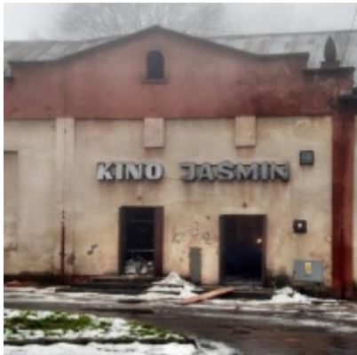
Rozbudowa i remont Regionalnego Ośrodka Kultury
