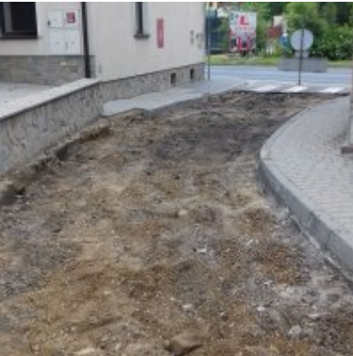
Remont ulicy Szkolnej w Zatorze
