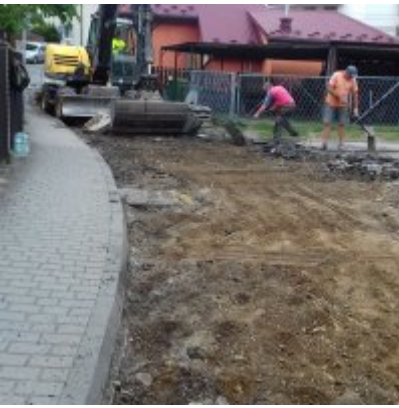
Remont ulicy Szkolnej w Zatorze
