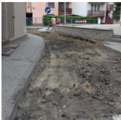
Remont ulicy Szkolnej w Zatorze
