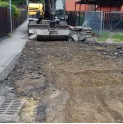
Remont ulicy Szkolnej w Zatorze
