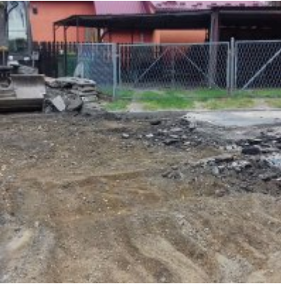
Remont ulicy Szkolnej w Zatorze
