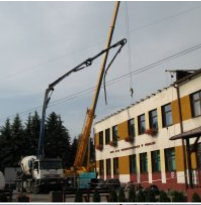
Remont dachu w ZSO Podolsze
