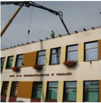
Remont dachu w ZSO Podolsze
