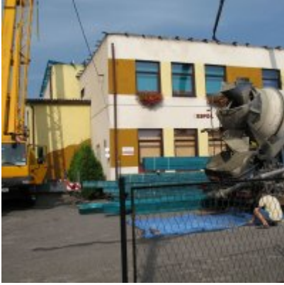
Remont dachu w ZSO Podolsze
