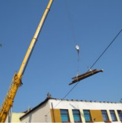
Remont dachu w ZSO Podolsze
