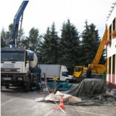
Remont dachu w ZSO Podolsze
