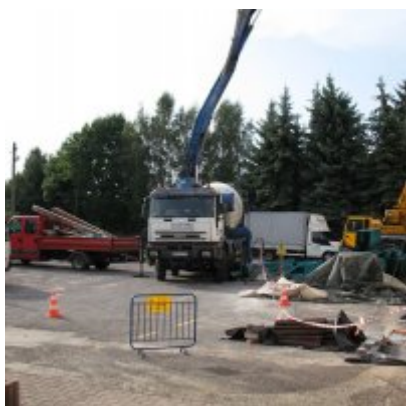
Remont dachu w ZSO Podolsze
