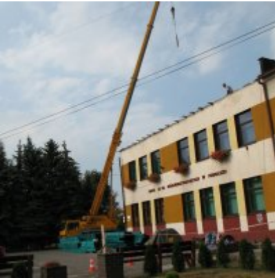
Remont dachu w ZSO Podolsze
