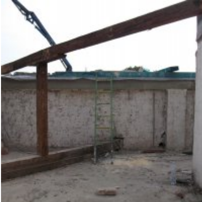
Remont dachu w ZSO Podolsze
