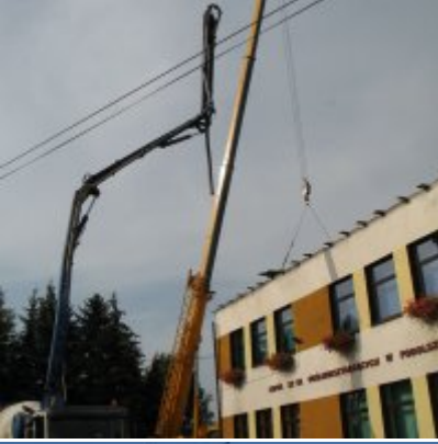
Remont dachu w ZSO Podolsze
