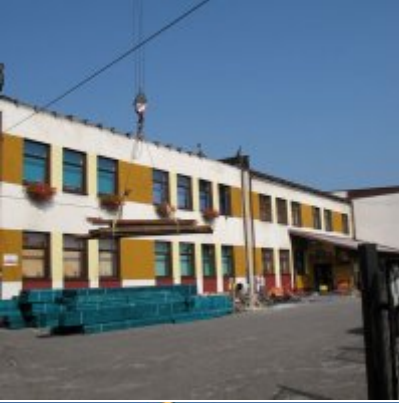
Remont dachu w ZSO Podolsze
