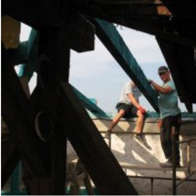
Remont dachu w ZSO Podolsze
