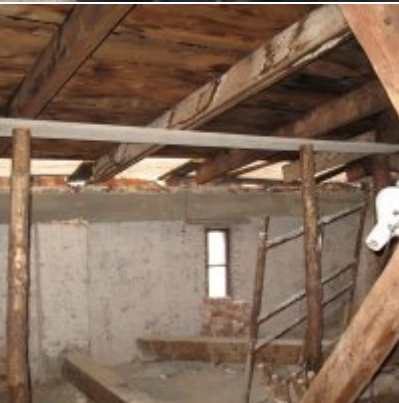
Remont dachu w ZSO Podolsze
