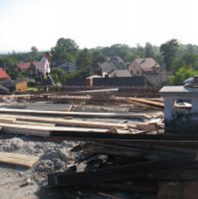
Remont dachu w ZSO Podolsze
