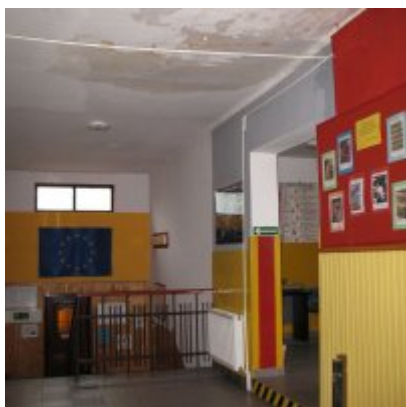
Remont dachu w ZSO Podolsze
