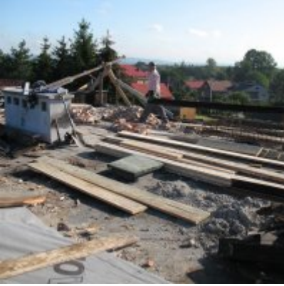
Remont dachu w ZSO Podolsze
