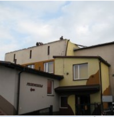
Remont dachu w ZSO Podolsze
