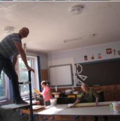
Remont dachu w ZSO Podolsze
