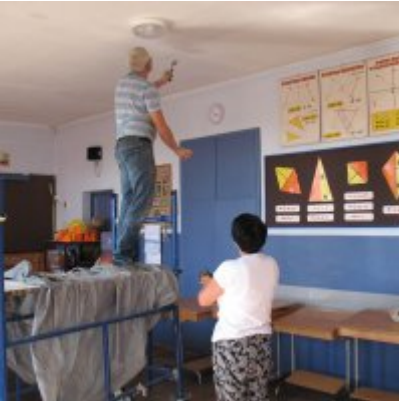
Remont dachu w ZSO Podolsze
