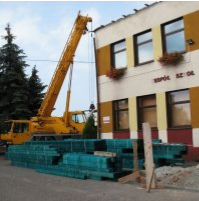
Remont dachu w ZSO Podolsze
