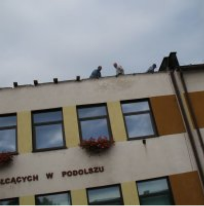
Remont dachu w ZSO Podolsze
