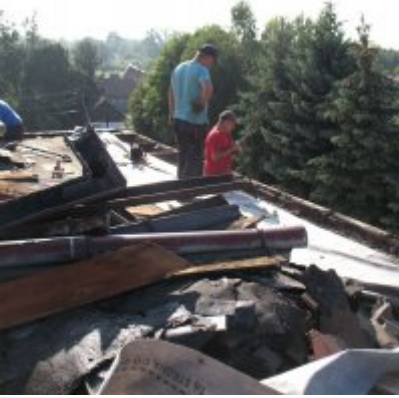
Remont dachu w ZSO Podolsze
