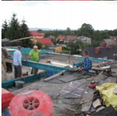
Remont dachu w ZSO Podolsze
