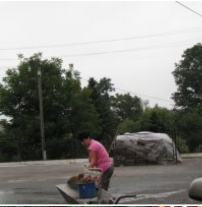
Remont dachu w ZSO Podolsze
