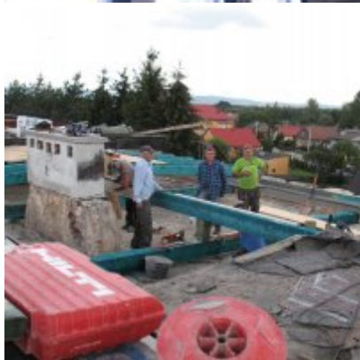
Remont dachu w ZSO Podolsze
