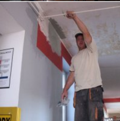
Remont dachu w ZSO Podolsze
