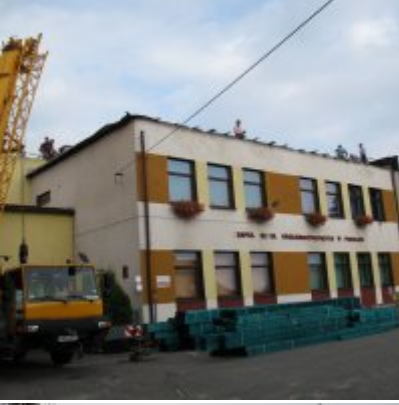
Remont dachu w ZSO Podolsze
