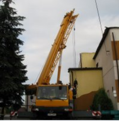
Remont dachu w ZSO Podolsze
