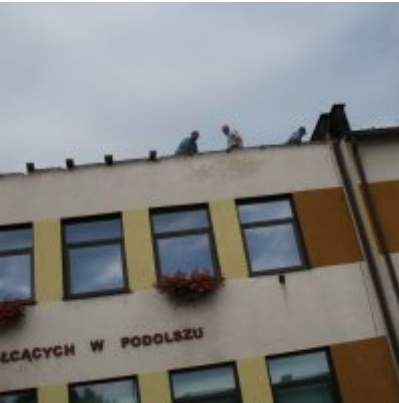
Remont dachu w ZSO Podolsze
