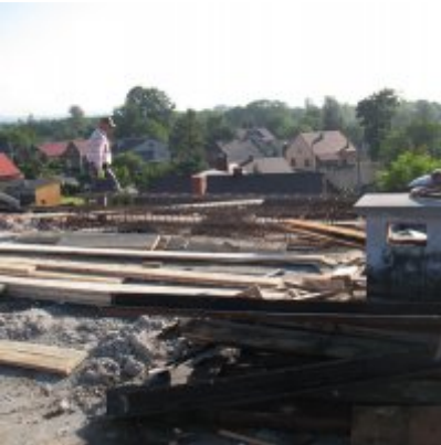
Remont dachu w ZSO Podolsze
