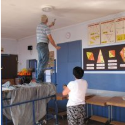
Remont dachu w ZSO Podolsze
