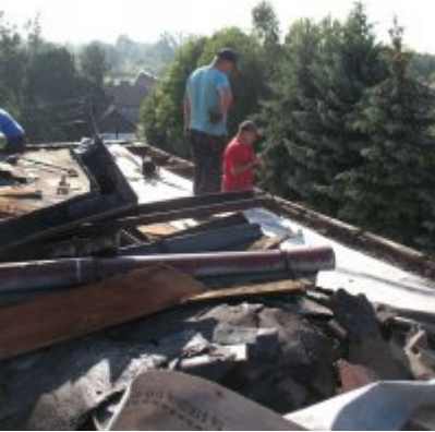
Remont dachu w ZSO Podolsze
