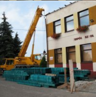
Remont dachu w ZSO Podolsze
