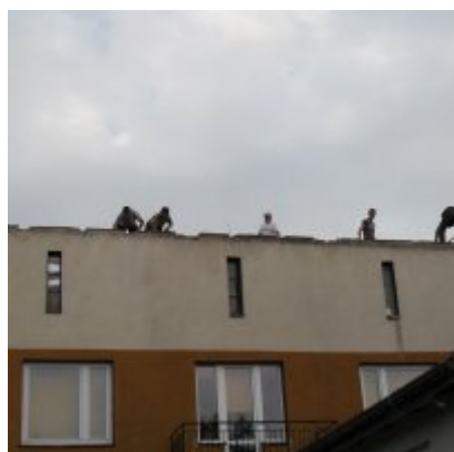
Remont dachu w ZSO Podolsze
