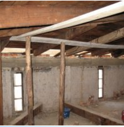
Remont dachu w ZSO Podolsze
