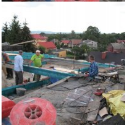
Remont dachu w ZSO Podolsze
