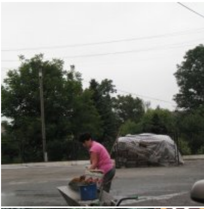
Remont dachu w ZSO Podolsze
