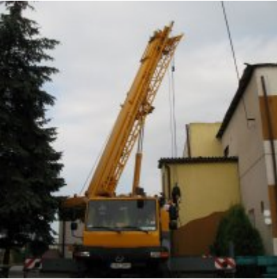
Remont dachu w ZSO Podolsze
