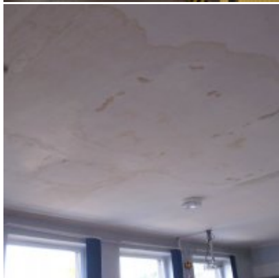
Remont dachu w ZSO Podolsze
