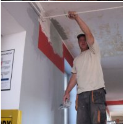
Remont dachu w ZSO Podolsze
