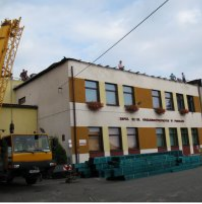
Remont dachu w ZSO Podolsze
