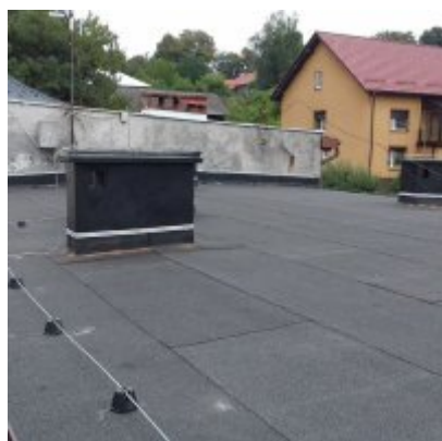
Remont dachu Szkoły podstawowej w Laskowej
