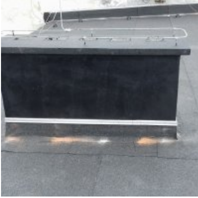
Remont dachu Szkoły podstawowej w Laskowej
