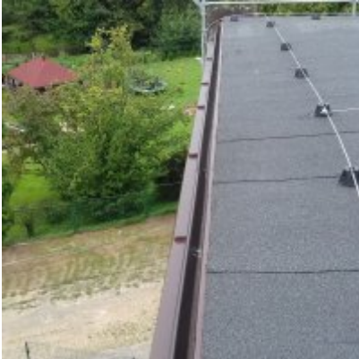
Remont dachu Szkoły podstawowej w Laskowej
