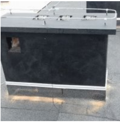
Remont dachu Szkoły podstawowej w Laskowej
