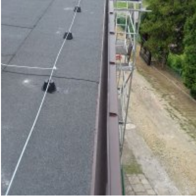
Remont dachu Szkoły podstawowej w Laskowej
