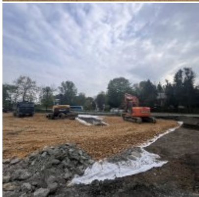
Realizacja zadania dot. „ Budowy Parkingu przy ul. Dolina Karpia w Zatorze”
