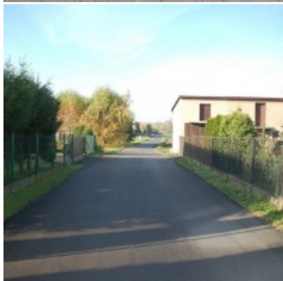
Przebudowa dróg w Gminie Zator
