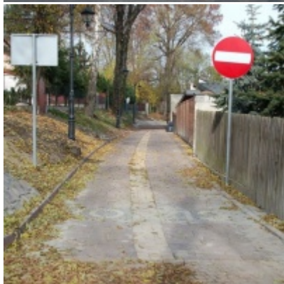
Przebudowa dróg w Gminie Zator
