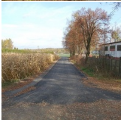
Przebudowa dróg w Gminie Zator
