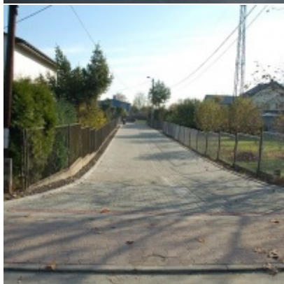
Przebudowa dróg w Gminie Zator
