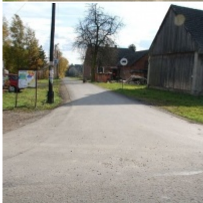
Przebudowa dróg w Gminie Zator
