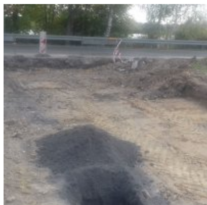
Prace budowlane na Al. Chopina w Zatorze
