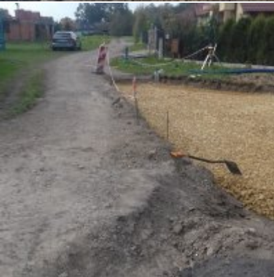
Prace budowlane na Al. Chopina w Zatorze
