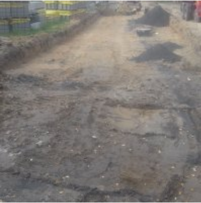
Prace budowlane na Al. Chopina w Zatorze
