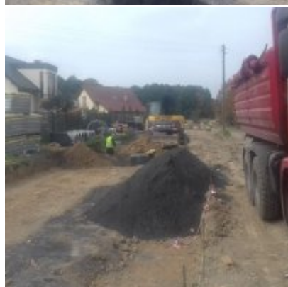
Prace budowlane na Al. Chopina w Zatorze
