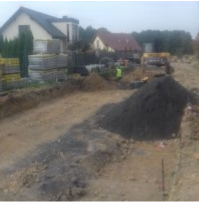
Prace budowlane na Al. Chopina w Zatorze
