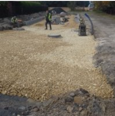
Prace budowlane na Al. Chopina w Zatorze
