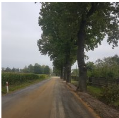
Praca wre - modernizacja drogi wojewódzkiej.
