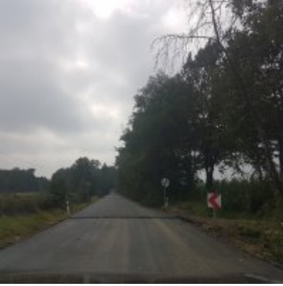
Praca wre - modernizacja drogi wojewódzkiej.
