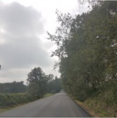
Praca wre - modernizacja drogi wojewódzkiej.
