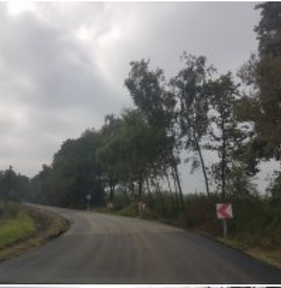
Praca wre - modernizacja drogi wojewódzkiej.
