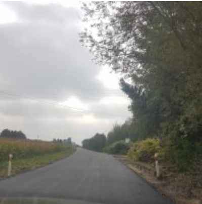
Praca wre - modernizacja drogi wojewódzkiej.
