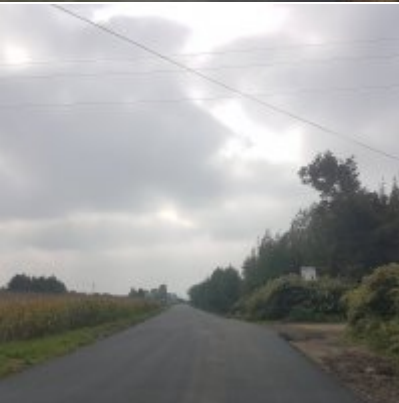
Praca wre - modernizacja drogi wojewódzkiej.
