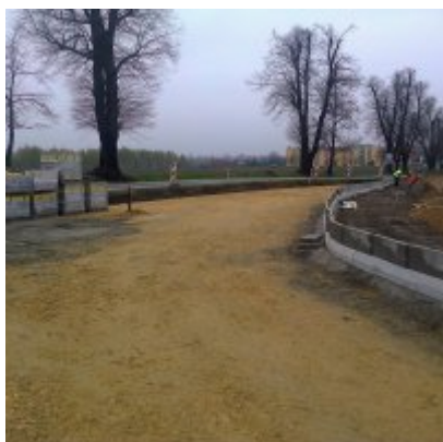
2016-04-13 Bieżący stan prac przy budowie ronda
