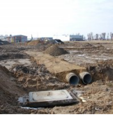
Postęp prac na budowie ronda w ciągu drogi krajowej nr 44
