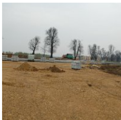
2016-04-13 Bieżący stan prac przy budowie ronda
