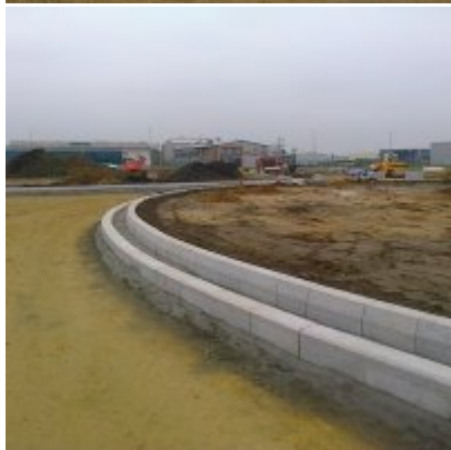
2016-04-13 Bieżący stan prac przy budowie ronda
