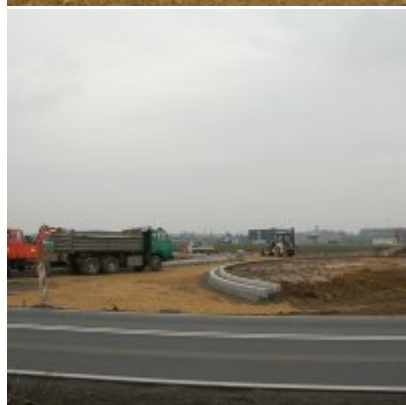
2016-04-13 Bieżący stan prac przy budowie ronda
