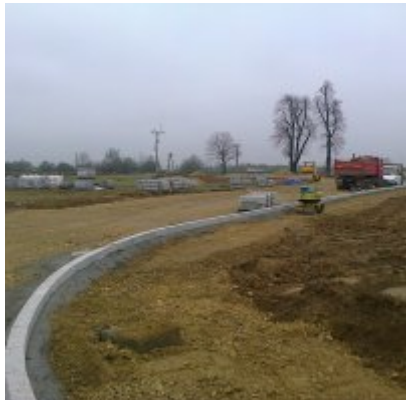
2016-04-13 Bieżący stan prac przy budowie ronda
