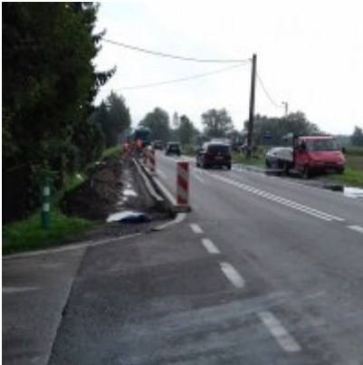
Poprawa bezpieczeństwa ruchu drogowego na odcinku Rudze - Trzebieńczyce.
