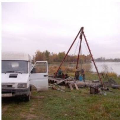
Nowe ujęcie wody pitnej
