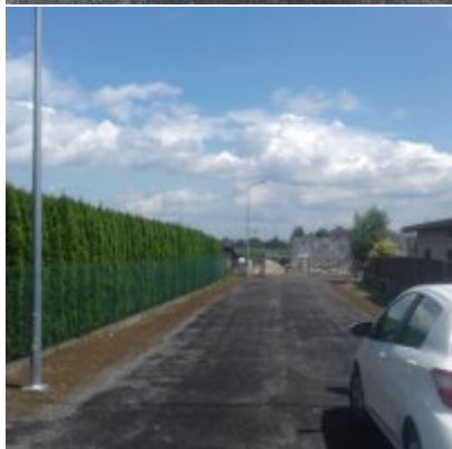
Modernizacja ul. Grunwaldzkiej
