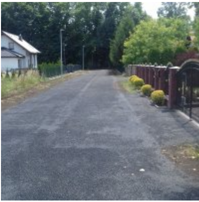
Modernizacja ul. Grunwaldzkiej
