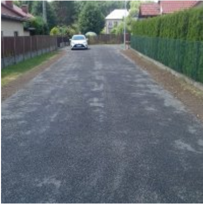
Modernizacja ul. Grunwaldzkiej
