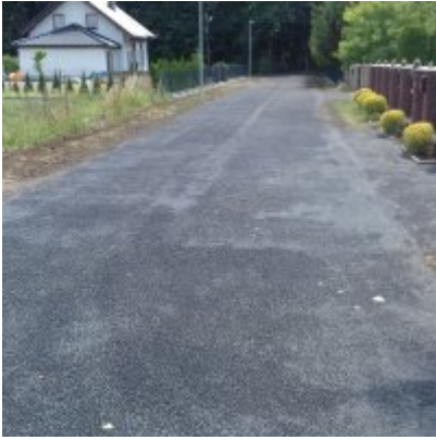
Modernizacja ul. Grunwaldzkiej
