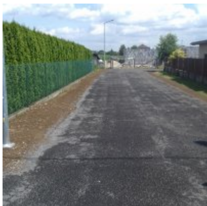
Modernizacja ul. Grunwaldzkiej
