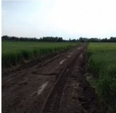
Modernizacja drogi wewnętrznej
