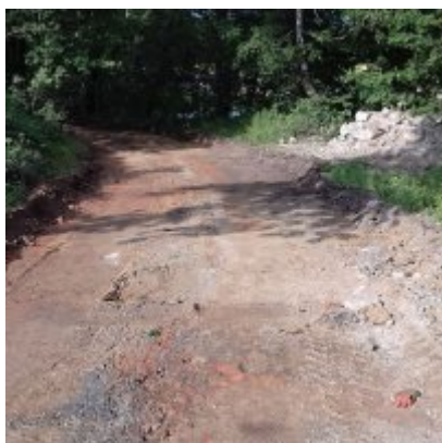
Modernizacja drogi wewnętrznej
