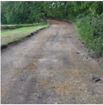
Modernizacja drogi wewnętrznej
