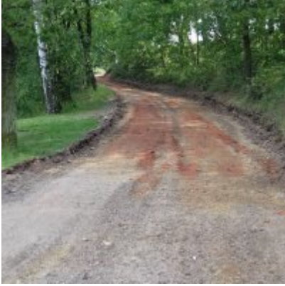
Modernizacja drogi wewnętrznej
