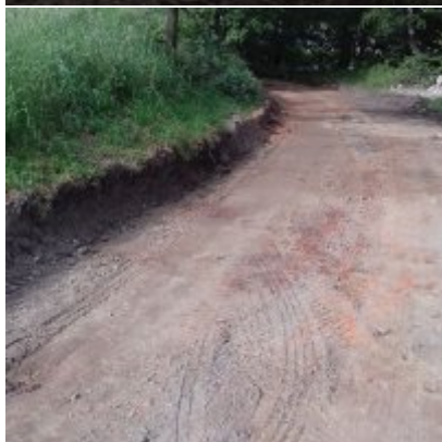
Modernizacja drogi wewnętrznej
