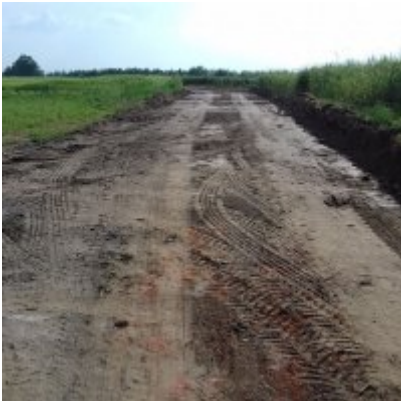
Modernizacja drogi wewnętrznej
