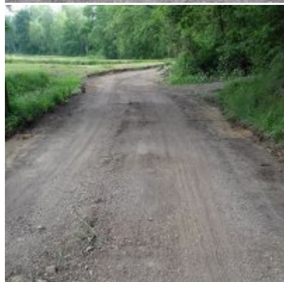
Modernizacja drogi wewnętrznej
