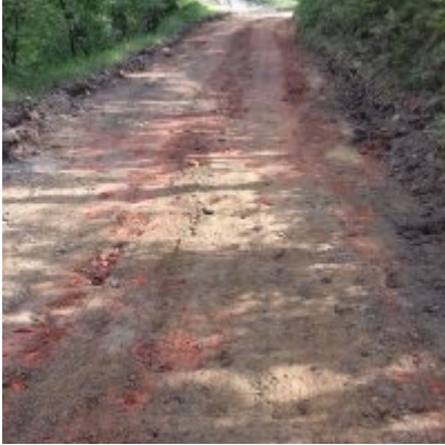
Modernizacja drogi wewnętrznej
