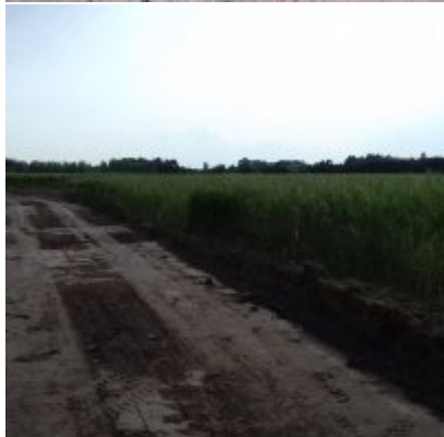
Modernizacja drogi wewnętrznej
