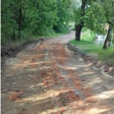
Modernizacja drogi wewnętrznej
