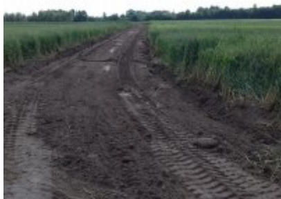
Modernizacja drogi wewnętrznej
