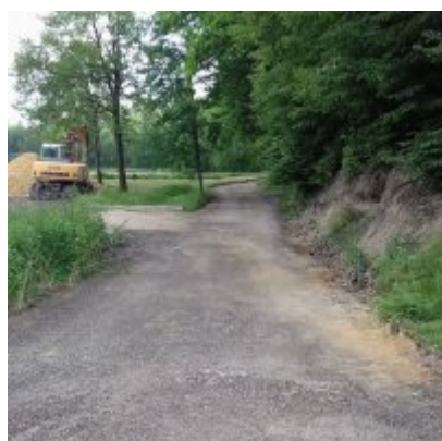
Modernizacja drogi wewnętrznej
