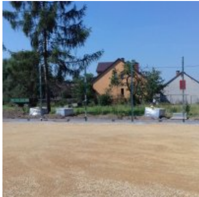
Modernizacja boiska przy Zespole Szkolno-Przedszkolnym w Podolszu, Gmina Zator
