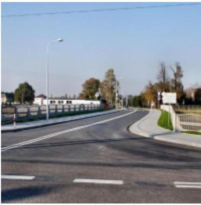
Kompleksowa modernizacja ciągu komunikacyjnego - ul. J. Słowackiego
