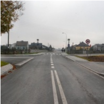
Kompleksowa modernizacja ciągu komunikacyjnego - ul. J. Słowackiego
