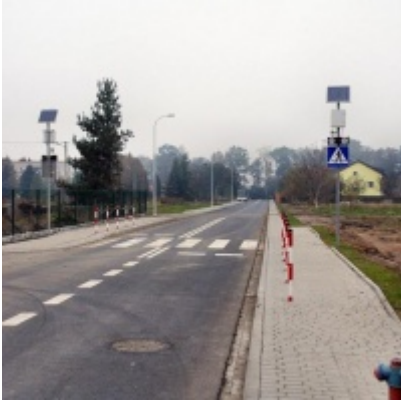
Kompleksowa modernizacja ciągu komunikacyjnego - ul. J. Słowackiego
