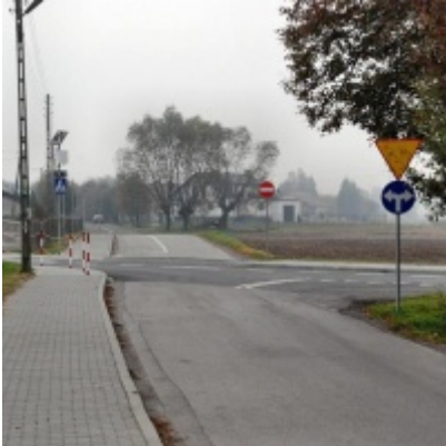
Kompleksowa modernizacja ciągu komunikacyjnego - ul. J. Słowackiego
