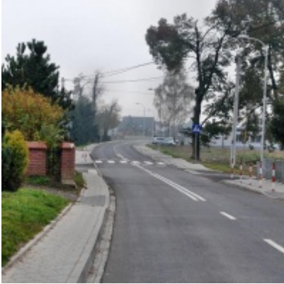
Kompleksowa modernizacja ciągu komunikacyjnego - ul. J. Słowackiego
