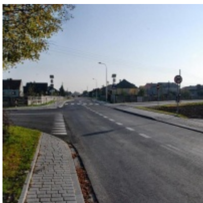
Kompleksowa modernizacja ciągu komunikacyjnego - ul. J. Słowackiego
