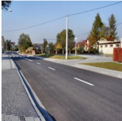
Kompleksowa modernizacja ciągu komunikacyjnego - ul. J. Słowackiego
