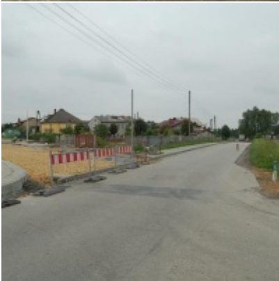
Kompleksowa modernizacja ciągu komunikacyjnego - ul. J. Słowackiego
