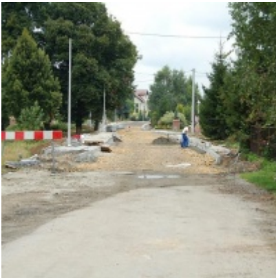
Kompleksowa modernizacja ciągu komunikacyjnego - ul. J. Słowackiego
