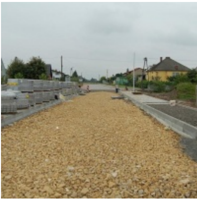
Kompleksowa modernizacja ciągu komunikacyjnego - ul. J. Słowackiego
