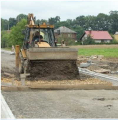
Kompleksowa modernizacja ciągu komunikacyjnego - ul. J. Słowackiego
