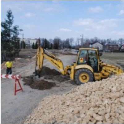
Kompleksowa modernizacja ciągu komunikacyjnego - ul. J. Słowackiego
