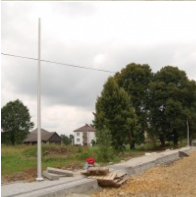
Kompleksowa modernizacja ciągu komunikacyjnego - ul. J. Słowackiego
