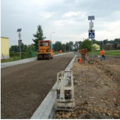
Kompleksowa modernizacja ciągu komunikacyjnego - ul. J. Słowackiego
