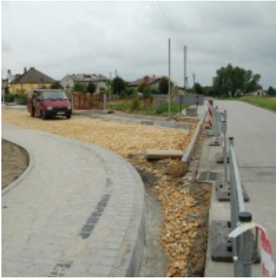
Kompleksowa modernizacja ciągu komunikacyjnego - ul. J. Słowackiego
