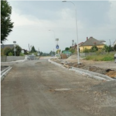
Kompleksowa modernizacja ciągu komunikacyjnego - ul. J. Słowackiego
