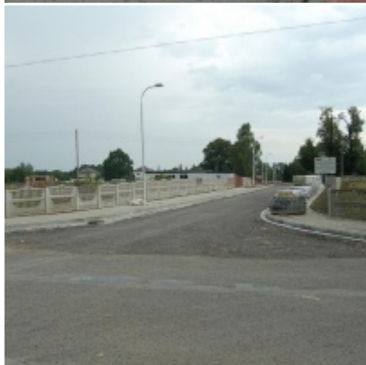
Kompleksowa modernizacja ciągu komunikacyjnego - ul. J. Słowackiego
