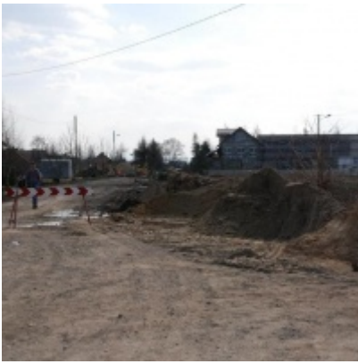
Kompleksowa modernizacja ciągu komunikacyjnego - ul. J. Słowackiego
