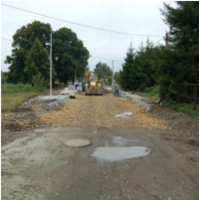
Kompleksowa modernizacja ciągu komunikacyjnego - ul. J. Słowackiego
