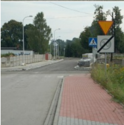
Kompleksowa modernizacja ciągu komunikacyjnego - ul. J. Słowackiego
