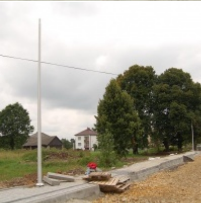
Kompleksowa modernizacja ciągu komunikacyjnego - ul. J. Słowackiego
