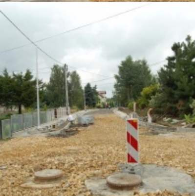
Kompleksowa modernizacja ciągu komunikacyjnego - ul. J. Słowackiego
