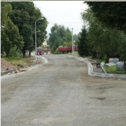
Kompleksowa modernizacja ciągu komunikacyjnego - ul. J. Słowackiego
