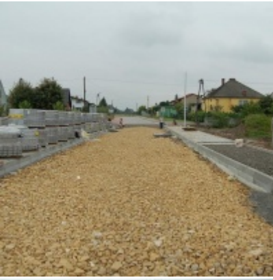
Kompleksowa modernizacja ciągu komunikacyjnego - ul. J. Słowackiego
