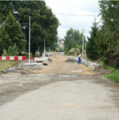
Kompleksowa modernizacja ciągu komunikacyjnego - ul. J. Słowackiego
