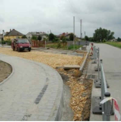
Kompleksowa modernizacja ciągu komunikacyjnego - ul. J. Słowackiego
