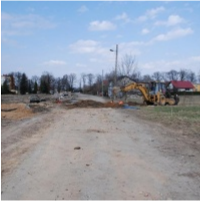
Kompleksowa modernizacja ciągu komunikacyjnego - ul. J. Słowackiego
