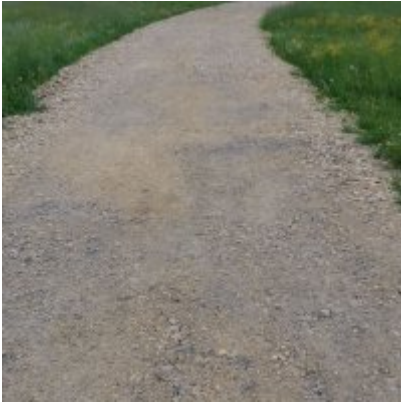
Rozpoczęcie robót dróg
