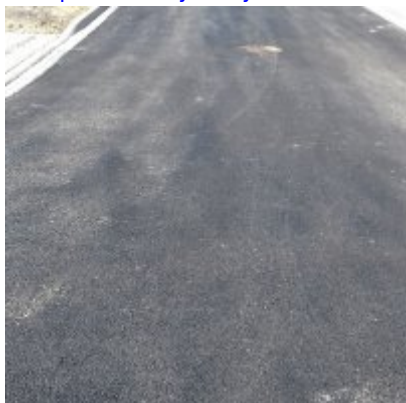
Budowa publicznej drogi gminnej na działce nr 81/20 obr. 0004 w Zatorze, o dł. ok. 85 mb oraz przebudowy skrzyżowania ul. Słowackiego z ul. Mickiewicza -149.000,00 zł.
