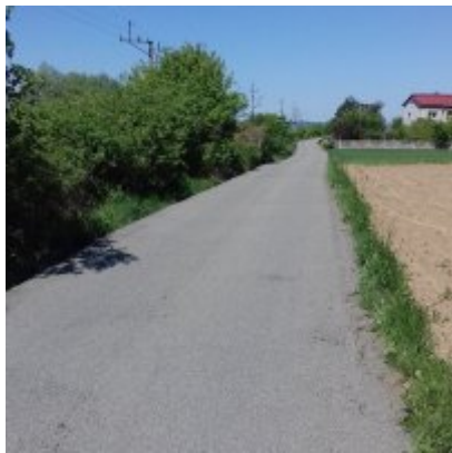
Rozpoczęcie robót remontowych
