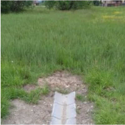
Rozpoczęcie robót dróg
