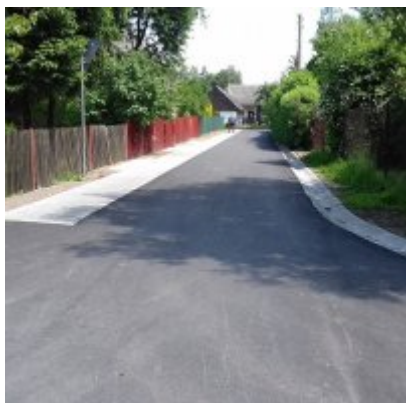
Zakończenie budowy drogi przez wieś w Palczowicach (ok 80 mb). Wartość robót 86.978,23 zł.
