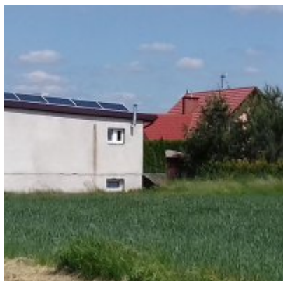
Zakończenie Modernizacji budynku gminnego w Trzebieńczycach nr 62, z przeznaczeniem dla potrzeb Rady Sołeckiej w Trzebieńczycach. Wartość robót 84.000,00 zł.
