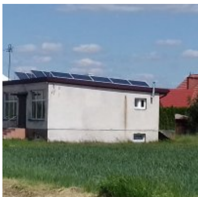
Zakończenie Modernizacji budynku gminnego w Trzebieńczycach nr 62, z przeznaczeniem dla potrzeb Rady Sołeckiej w Trzebieńczycach. Wartość robót 84.000,00 zł.
