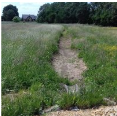
Rozpoczęcie robót dróg
