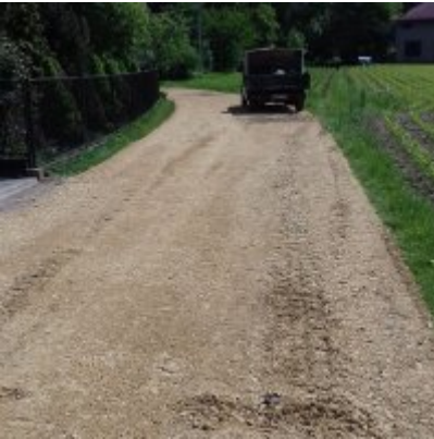
Modernizacja odcinka drogi wewnętrznej w stronę Skawy w Graboszycach, na dł. ok. 115 mb, masą bitumiczną. Wartość zadania 28.413,00 zł.
