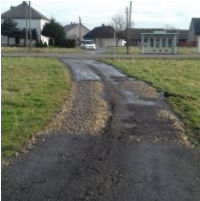
Rozpoczęcie robót dróg
