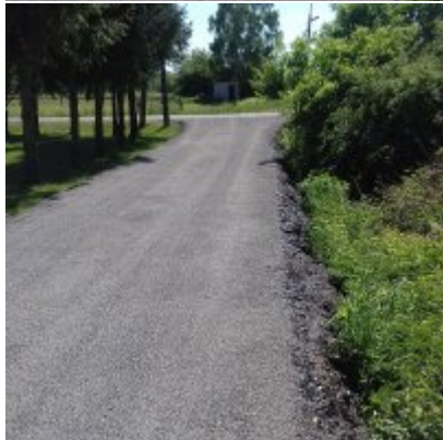
Rozpoczęcie robót remontowych
