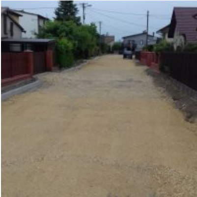
Budowa drogi – ul. Ks. Władysława w Zatorze (ok. 110 mb) -129.380,00 zł .
