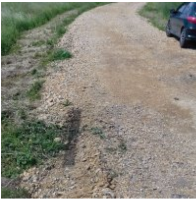
Rozpoczęcie robót dróg
