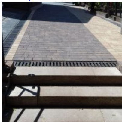
Zakończenie robót przy Przebudowie ul. Stromej w Zatorze wraz z przebudową schodów terenowych i odwodnienia oraz budową oświetlenia ulicznego. Wartość robót 277.940,01 zł.
