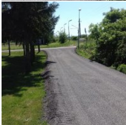
Rozpoczęcie robót remontowych
