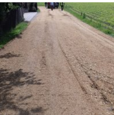
Modernizacja odcinka drogi wewnętrznej nr 185K prowadzącej do pól w Graboszycach, na dł.
