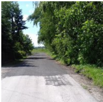
Rozpoczęcie modernizacji nawierzchni ul. Hallera w Zatorze, na dł. ok. 390 mb, emulsją i grysem kamiennym. Wartość zadania 27.552,00 zł.
