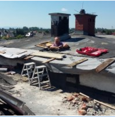
MODERNIZACJA DACHU NA BUDYNKU ZSO w PODOLSZU
