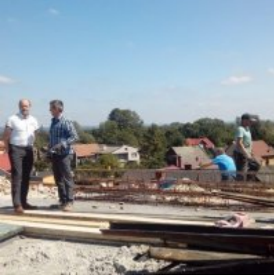
MODERNIZACJA DACHU NA BUDYNKU ZSO w PODOLSZU
