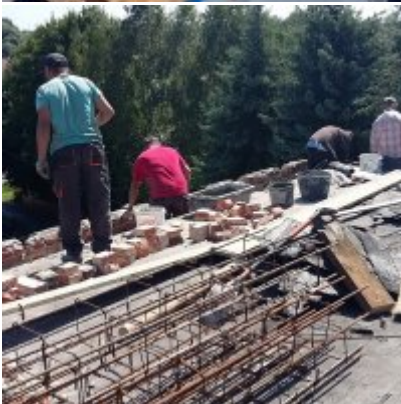
MODERNIZACJA DACHU NA BUDYNKU ZSO w PODOLSZU
