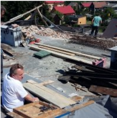
MODERNIZACJA DACHU NA BUDYNKU ZSO w PODOLSZU
