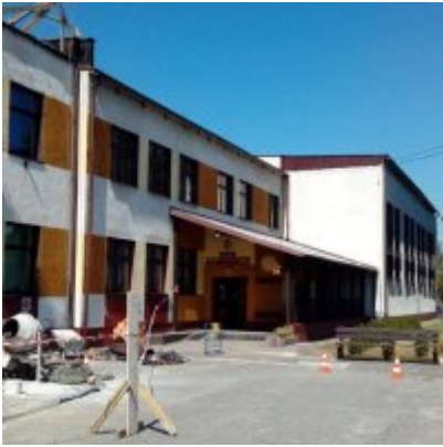
MODERNIZACJA DACHU NA BUDYNKU ZSO w PODOLSZU
