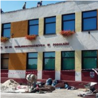
MODERNIZACJA DACHU NA BUDYNKU ZSO w PODOLSZU
