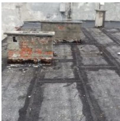
Prace remontowe na jednym z budynków gminnych przy szkole w Laskowej
