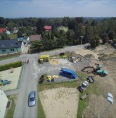
Budowa miejsc postojowych dla samochodów osobowych przy ul. Kongresowej w Zatorze.
