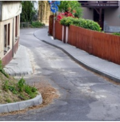
Inwestycje drogowe realizowane w 2009 r. - Szkolna
