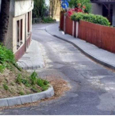
Inwestycje drogowe realizowane w 2009 r. - Szkolna
