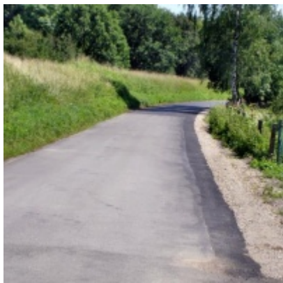
Inwestycje drogowe realizowane w 2009 r. - Wałowa
