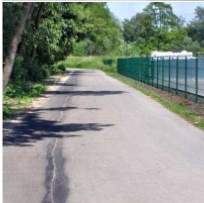
Inwestycje drogowe realizowane w 2009 r. - Wałowa
