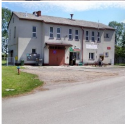
Inwestycje drogowe realizowane w 2009 r. - Plac w Smolicach przed remontem
