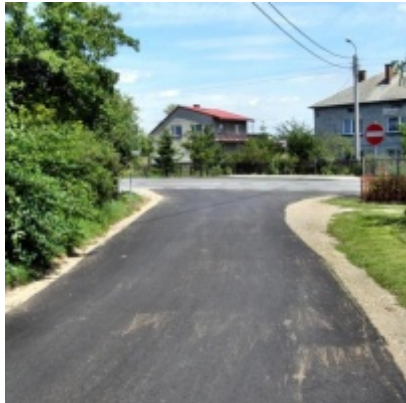
Inwestycje drogowe realizowane w 2009 r. - Starowiejska
