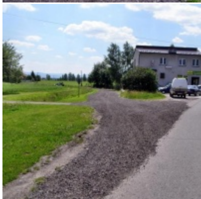
Inwestycje drogowe realizowane w 2009 r. - Stawowa
