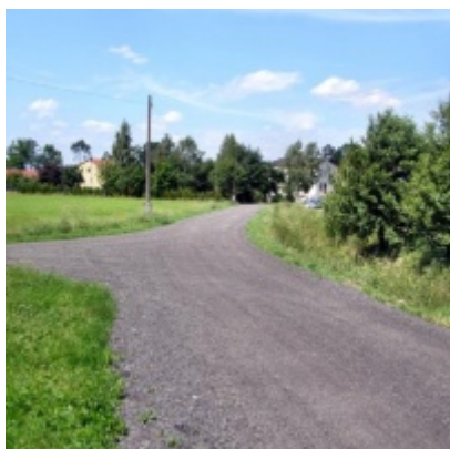
Inwestycje drogowe realizowane w 2009 r. - Stawowa
