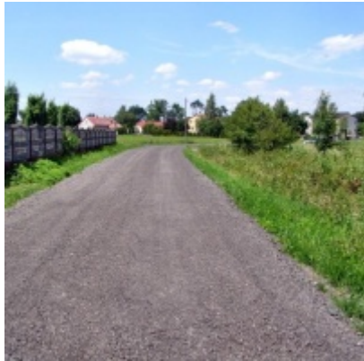
Inwestycje drogowe realizowane w 2009 r. - Stawowa
