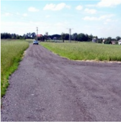
Inwestycje drogowe realizowane w 2009 r. - Graboszyce
