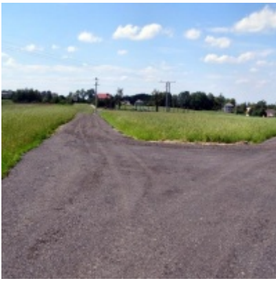
Inwestycje drogowe realizowane w 2009 r. - Graboszyce
