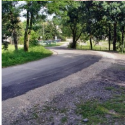
Inwestycje drogowe realizowane w 2009 r. - Droga Piastowski
