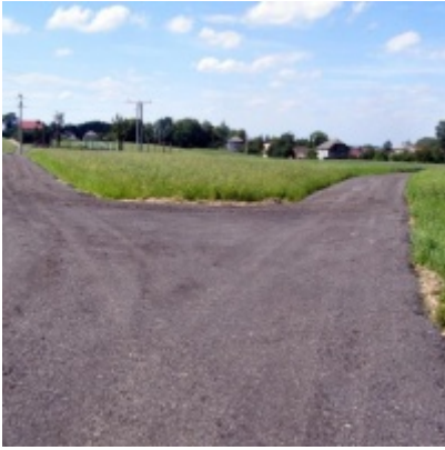
Inwestycje drogowe realizowane w 2009 r. - Graboszyce
