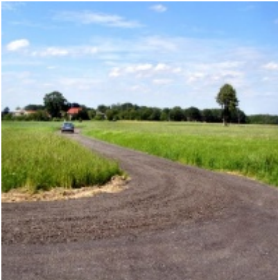
Inwestycje drogowe realizowane w 2009 r. - Graboszyce
