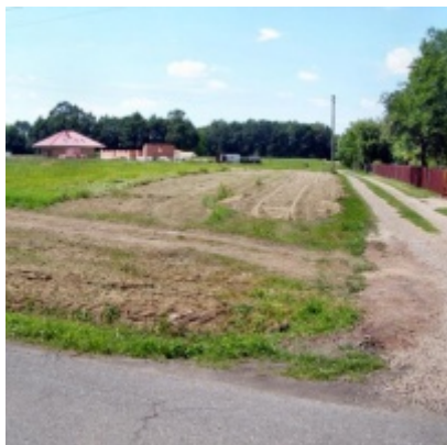
Inwestycje drogowe realizowane w 2009 r. - Brzezina
