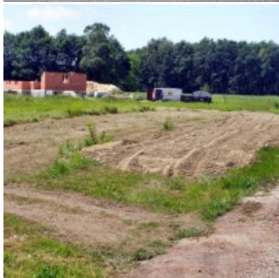
Inwestycje drogowe realizowane w 2009 r. - Brzezina
