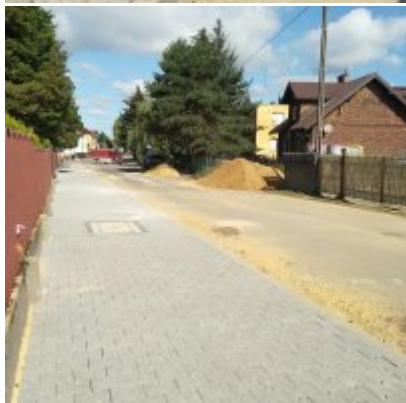
Remont chodnika - ul. Kongresowa w Zatorze
