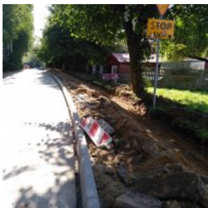
Remont chodnika - ul. Kongresowa w Zatorze
