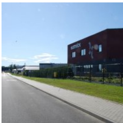
Fotogaleria Zatorskiej Strefy Aktywności Gospodarczej
