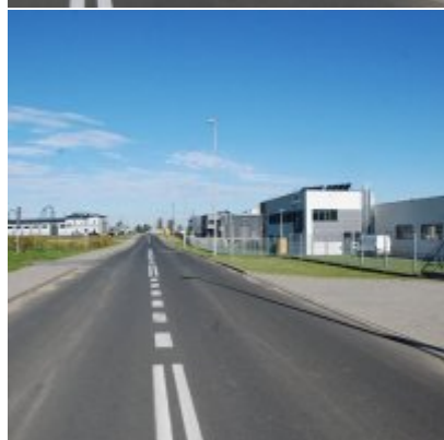
Fotogaleria Zatorskiej Strefy Aktywności Gospodarczej
