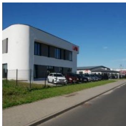
Fotogaleria Zatorskiej Strefy Aktywności Gospodarczej
