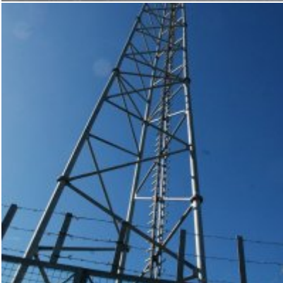
Fotogaleria Zatorskiej Strefy Aktywności Gospodarczej
