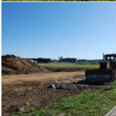
Fotogaleria Zatorskiej Strefy Aktywności Gospodarczej
