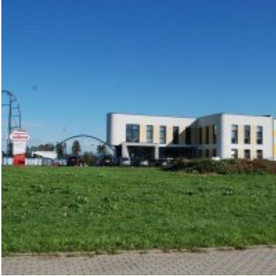
Fotogaleria Zatorskiej Strefy Aktywności Gospodarczej
