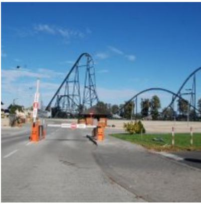
Fotogaleria Zatorskiej Strefy Aktywności Gospodarczej
