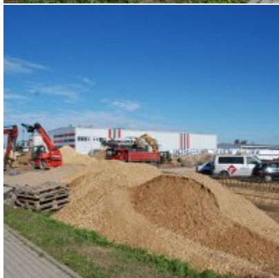
Fotogaleria Zatorskiej Strefy Aktywności Gospodarczej
