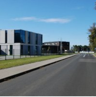
Fotogaleria Zatorskiej Strefy Aktywności Gospodarczej
