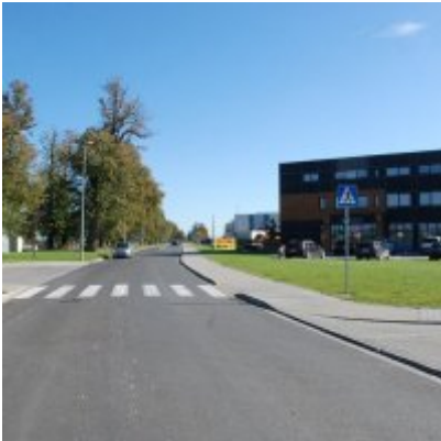
Fotogaleria Zatorskiej Strefy Aktywności Gospodarczej
