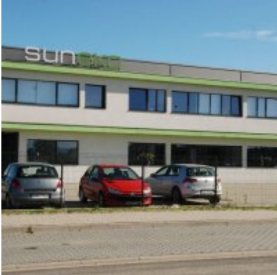
Fotogaleria Zatorskiej Strefy Aktywności Gospodarczej
