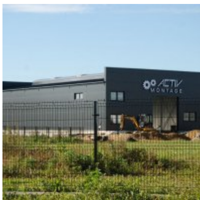
Fotogaleria Zatorskiej Strefy Aktywności Gospodarczej
