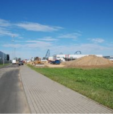
Fotogaleria Zatorskiej Strefy Aktywności Gospodarczej
