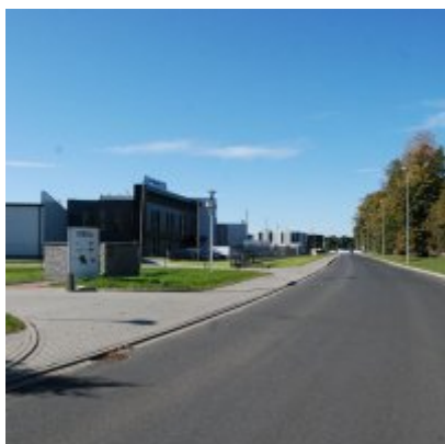
Fotogaleria Zatorskiej Strefy Aktywności Gospodarczej
