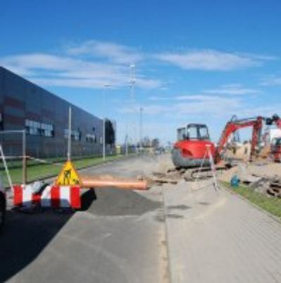
Fotogaleria Zatorskiej Strefy Aktywności Gospodarczej
