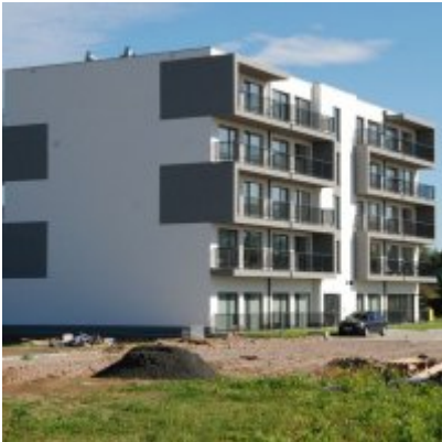
Fotogaleria Zatorskiej Strefy Aktywności Gospodarczej
