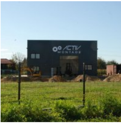
Fotogaleria Zatorskiej Strefy Aktywności Gospodarczej
