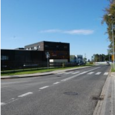
Fotogaleria Zatorskiej Strefy Aktywności Gospodarczej
