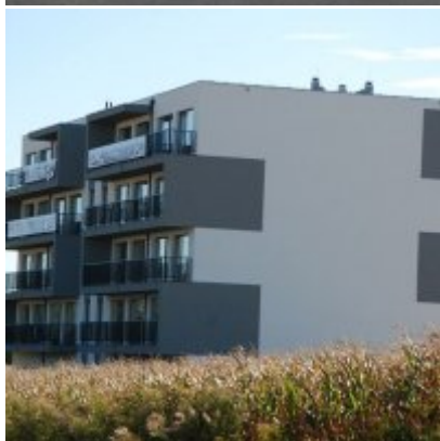
Fotogaleria Zatorskiej Strefy Aktywności Gospodarczej
