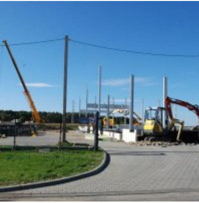
Fotogaleria Zatorskiej Strefy Aktywności Gospodarczej
