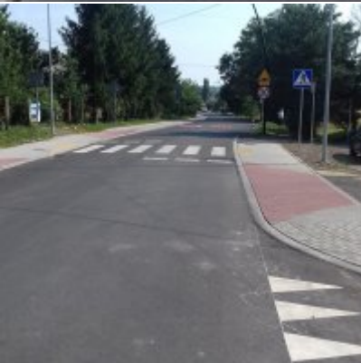
Droga powiatowa w Graboszycach już po modernizacji
