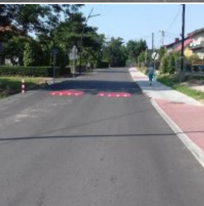
Droga powiatowa w Graboszycach już po modernizacji
