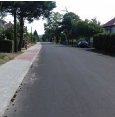
Droga powiatowa w Graboszycach już po modernizacji
