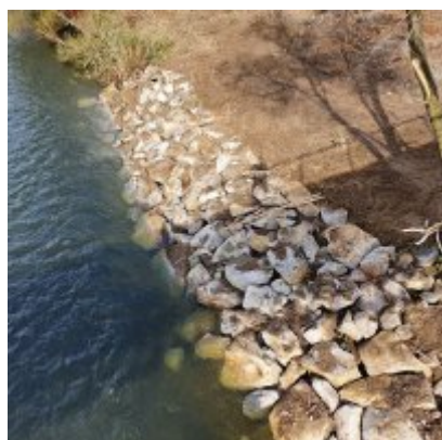
Zabezpieczenie brzegu odcinków Skawy w Gminie Zator
