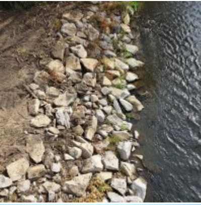
Zabezpieczenie brzegu odcinków Skawy w Gminie Zator
