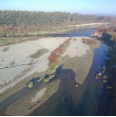
Zabezpieczenie brzegu odcinków Skawy w Gminie Zator
