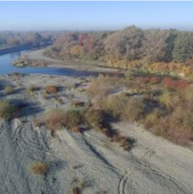
Zabezpieczenie brzegu odcinków Skawy w Gminie Zator
