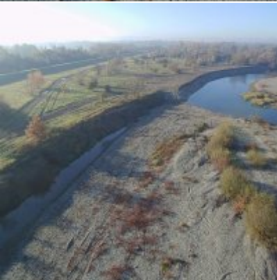
Zabezpieczenie brzegu odcinków Skawy w Gminie Zator
