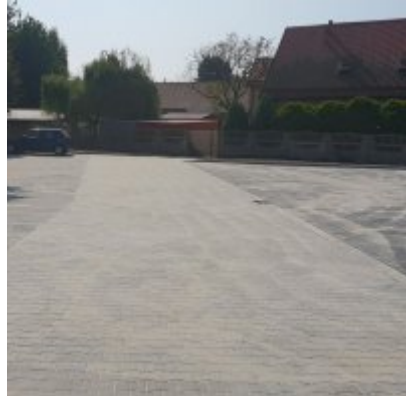
Budowa miejsc postojowych dla samochodów w Zatorze
