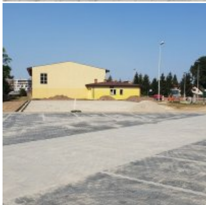
Budowa miejsc postojowych dla samochodów w Zatorze
