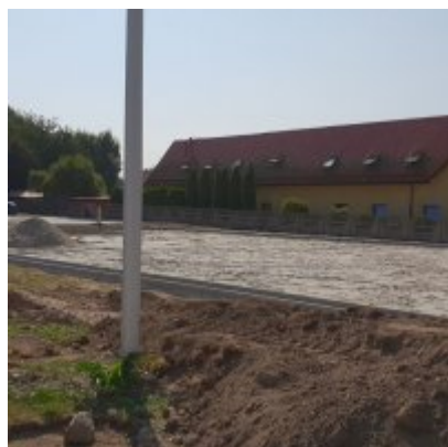
Budowa boiska sportowego o nawierzchni z trawy naturalnej przy ZSO w Zatorze
