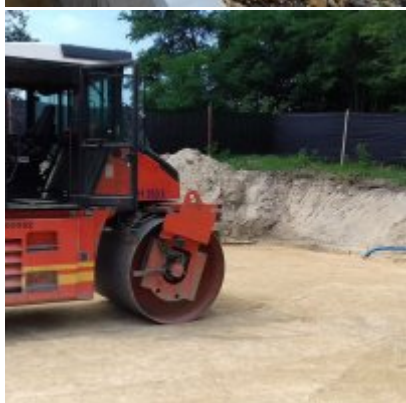
Budowa Punktu Selektywnej Zbiórki Odpadów Komunalnych w Gminie Zator
