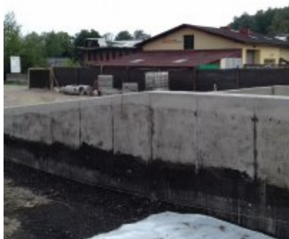
Budowa Punktu Selektywnej Zbiórki Odpadów Komunalnych w Gminie Zator
