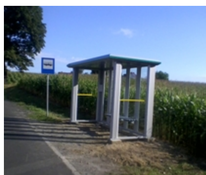
Graboszyce w stronę Zatora nowa wiata
