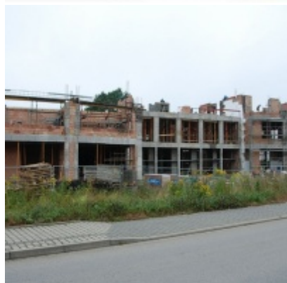
Budowa "Centrum Aktywizacji Zawodowej"
