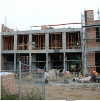
Budowa "Centrum Aktywizacji Zawodowej"
