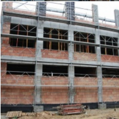
Budowa "Centrum Aktywizacji Zawodowej"
