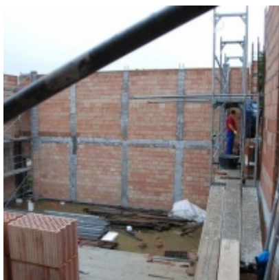
Budowa "Centrum Aktywizacji Zawodowej"
