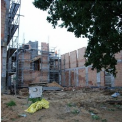
Budowa "Centrum Aktywizacji Zawodowej"
