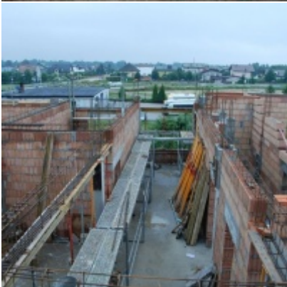
Budowa "Centrum Aktywizacji Zawodowej"
