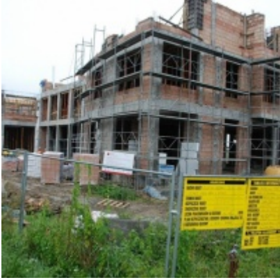
Budowa "Centrum Aktywizacji Zawodowej"
