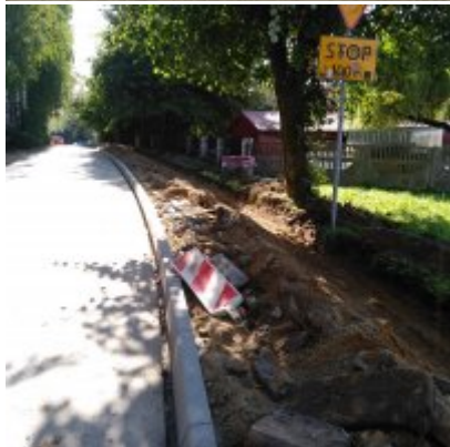
Remont chodnika - ul. Kongresowa w Zatorze
