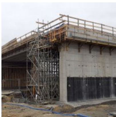
Postęp prac na budowie obwodnicy Podolsza DW 781
