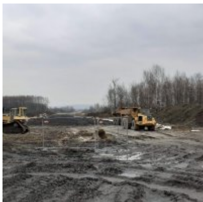
Postęp prac na budowie obwodnicy Podolsza DW 781
