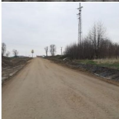
Postęp prac na budowie obwodnicy Podolsza DW 781
